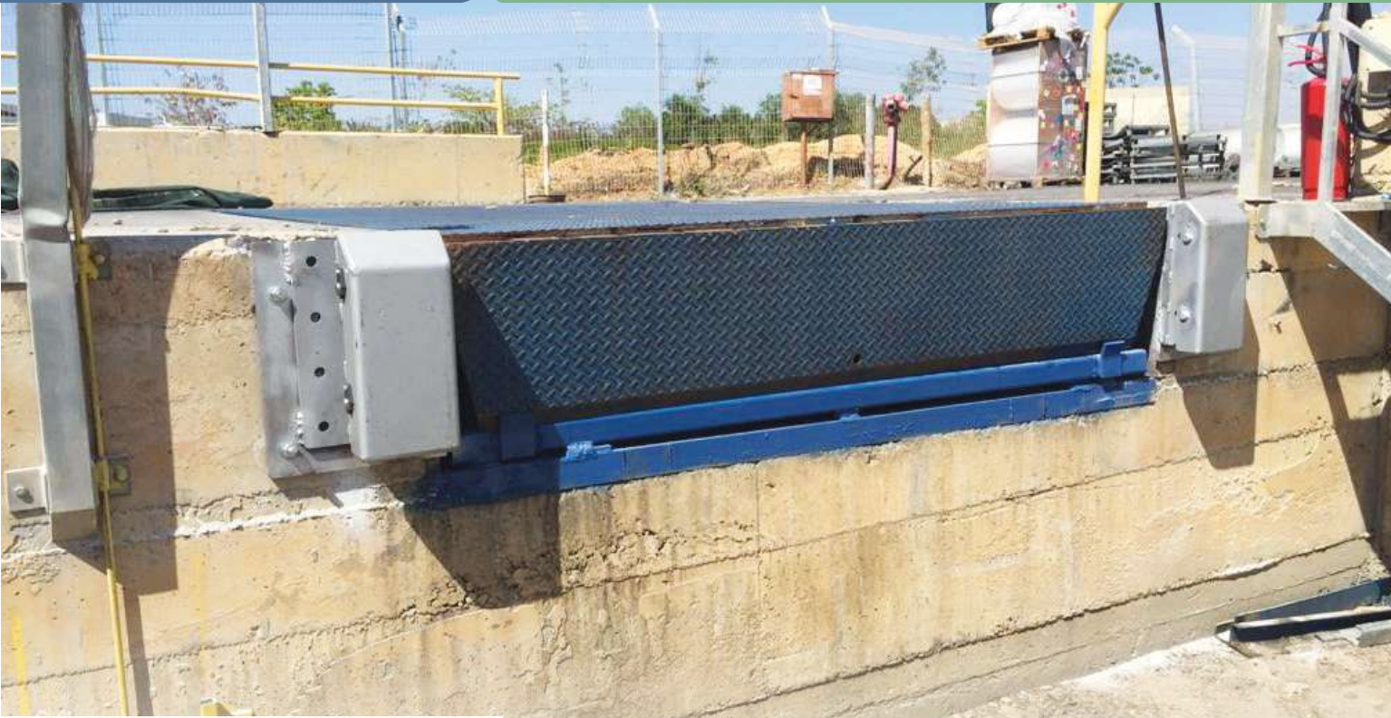
תמונה 2: בולמי אנרגיה משפרים למשווה גובה למשאיות.
