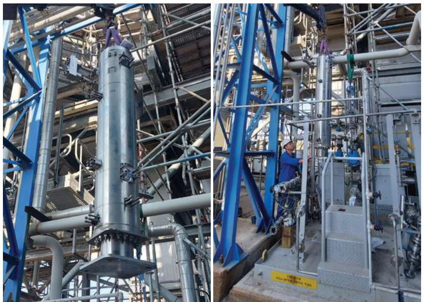
תמונה 1: מסנני John Crane הותקנו על ידי טכנוסיל בתחנת הכוח של בתי הזיקוק באשדוד.
