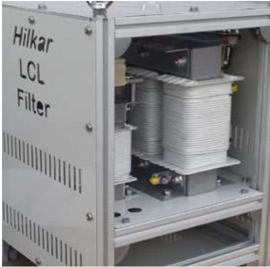
תמונה 3: מסנני הרמוניות. מימין: מסנן אקטיבי של חברת MERUS POWER, משמאל: מסנן פסיבי של חברת Hilkar.
