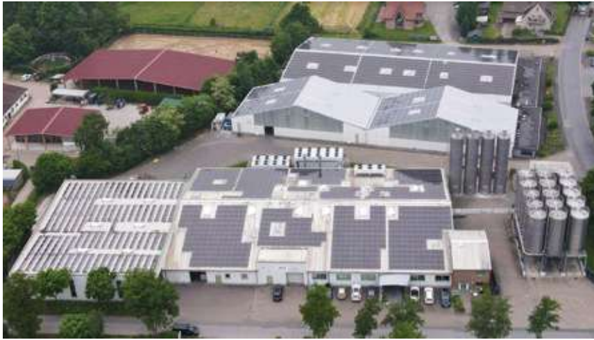
צילום מלמעלה, מפעל MCT פולרים בגרמניה. מחופה לוחות סולריים להפקת אנרגיה ירוקה.
