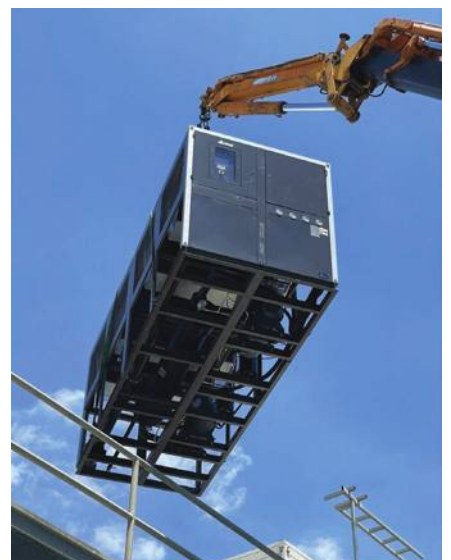
תמונה 1: התקנה של צ'ילרים תוצרת ANGES במפעל פלסטיק בישראל.
