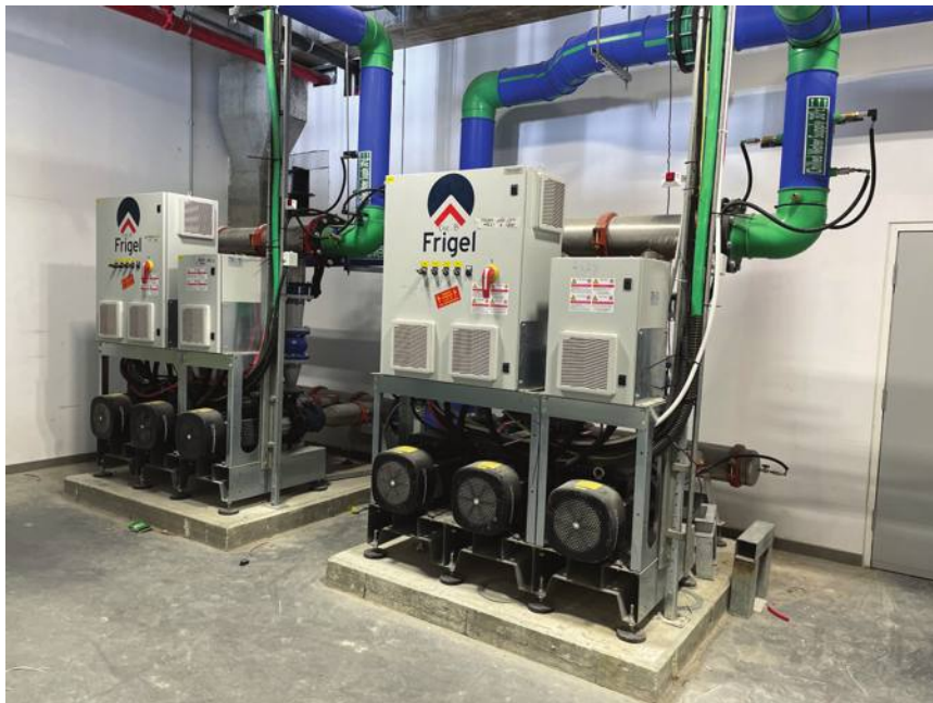
תמונה 2: מערכת משאבות ופיקוד משאבות לסחרור מי קירור לצרכנים.
