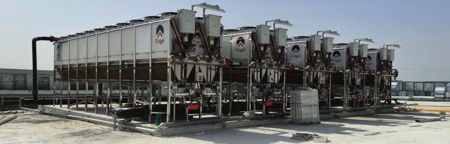
תמונה 1: מערכת אדיאבטית שהותקנה במפעל סודהסטרים. 5 מתקנים, 20 מאווררים מפוקדי תדר בכל מתקן של חברת Frigel.
