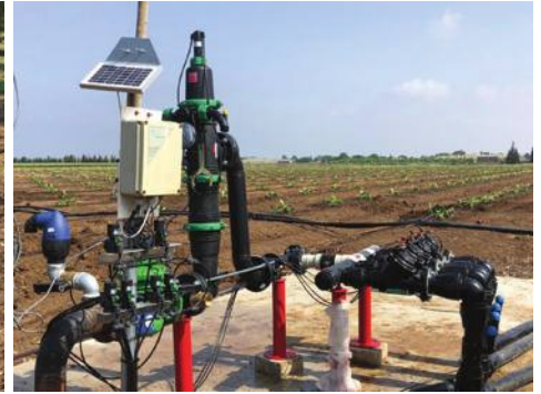
תמונה 2: מסנן המיני סיגמא האוטומטי של עמיעד מותקן בשטח בצורה אופקית ואנכית.
